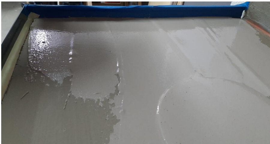
Hydroizolacja cokolik cofnięty – względem obrysu elewacji
